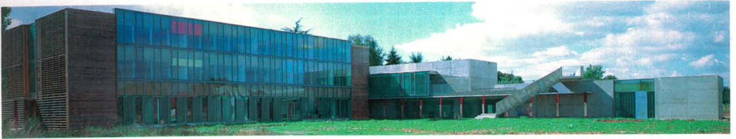
Façade arrière du bâtiment réhabilité et, refermant l'angle, le bâtiment neuf barré par l'oblique de l'escalier.
