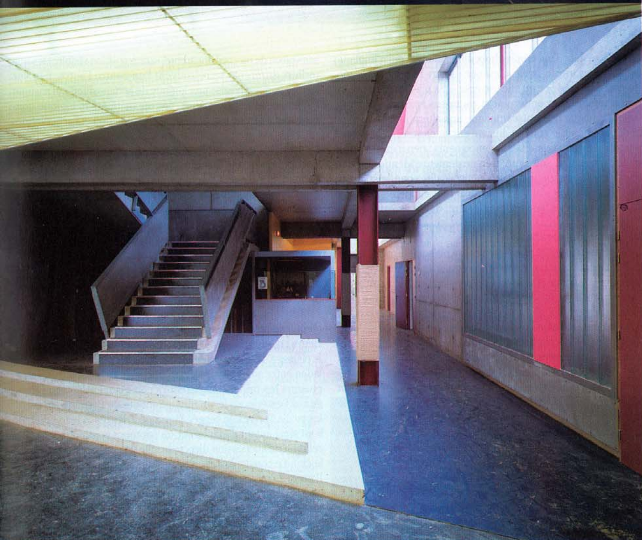
La file A vue de l'entrée. L'assemblage mêle béton et acier, sans pièce de raccord ni cordon de soudure visibles : les poutres semblent simplement enserrer le poteau.
