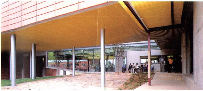
Ci-dessus, vue de l'entrée et de la salle de permanence, depuis le débouché du verger. Ci-dessous, la salle de permanence, à demi suspendue au dessus du passage des bus.
