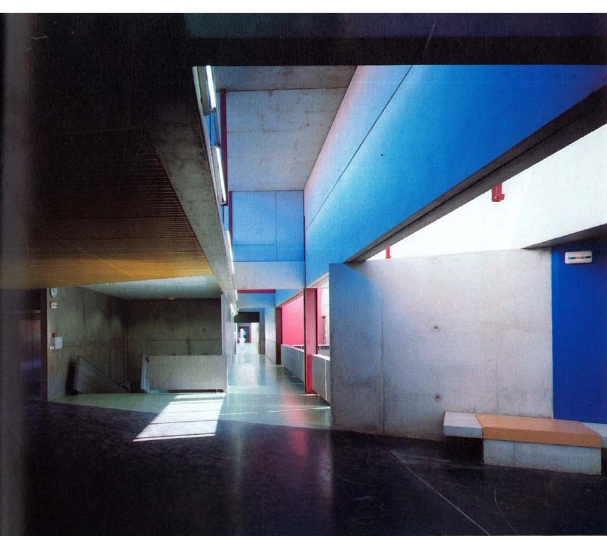
Le couloir de l'étage, vers les salles de langues vivantes. Dans cette section, la file A est en béton et les poteaux sont disposés transversalement.
