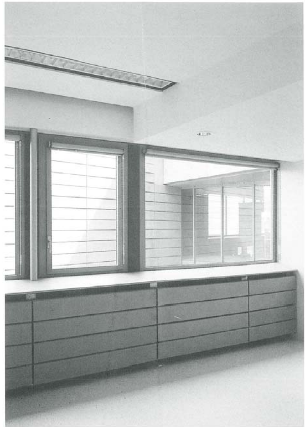
Façade interne d'une salle de classe. On retrouve la terre cuite à l'intérieur.
